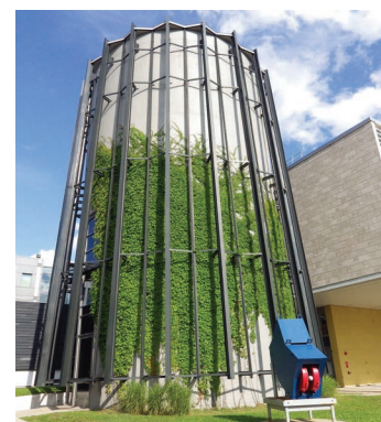
Le Colosse, un superordinateur installé dans l'ancienne structure en silo de l'accélérateur de particules remporte de nombreux prix d'efficacité énergétique.
