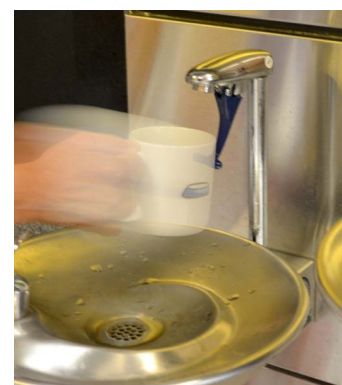
Fontaines permettant le remplissage facile des verres ou des tasses, un incitatif à réduire l'achat de bouteilles d'eau.
